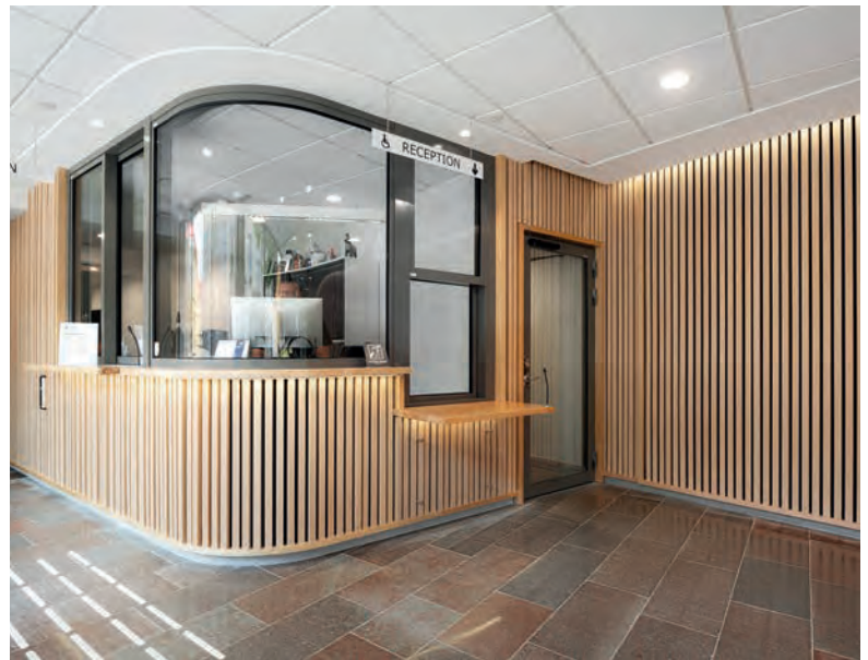
Säker reception med Svalson Ballistic® – skottskyddande partitioner i beskjutningsklass FB6, provade och godkända av RISE.
